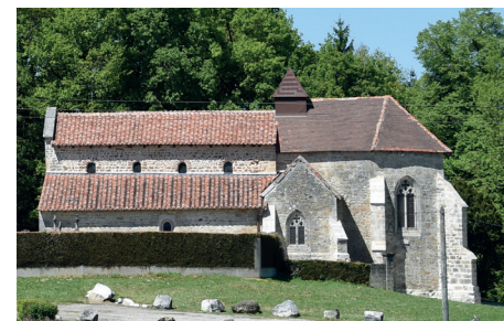
● Chapelle Saint-Aubin érigée sur une butte.
